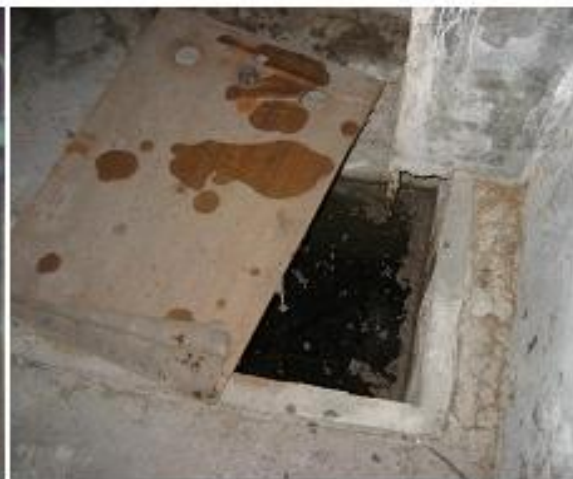
地下室污水池
