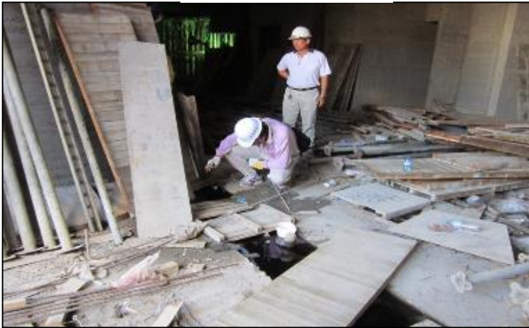
車道下方水溝
