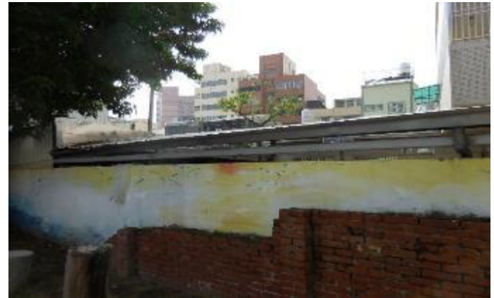
天溝(屋簷排水槽)
