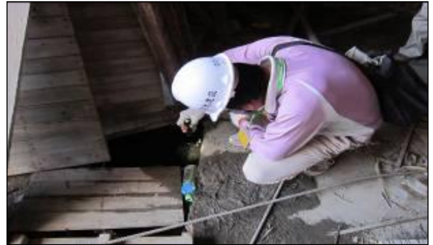
車道下方水溝
