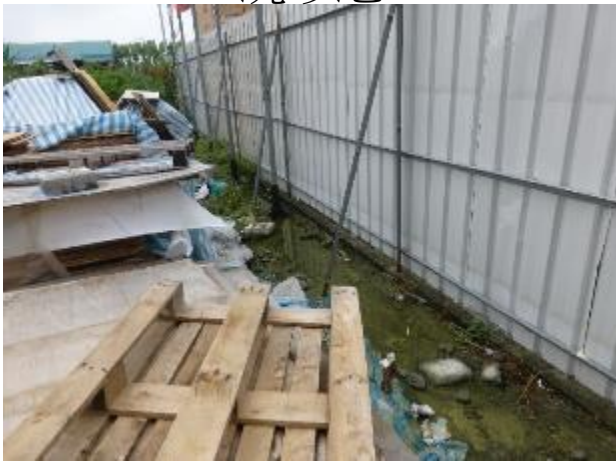
建築工地圍牆周邊
