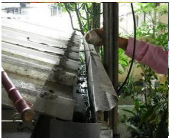
天溝(屋簷排水槽)
