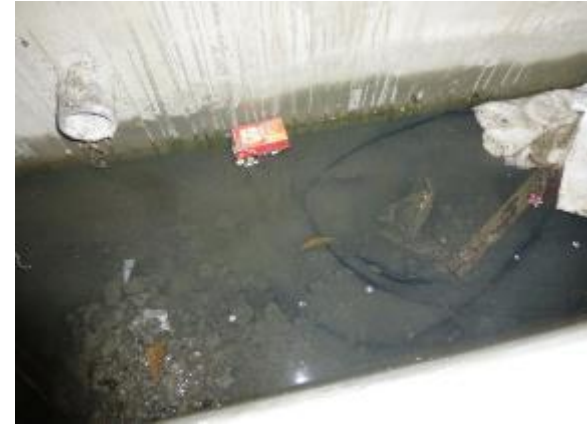
建築工地地面
